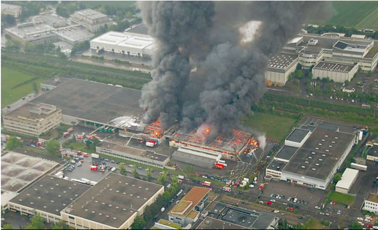
Luftbild der Einsatzstelle von Westen. Im Vordergrund befindet sich die Hanns-Klemm-Straße, hinter dem Brandobjekt die Eisenbahnlinie.
