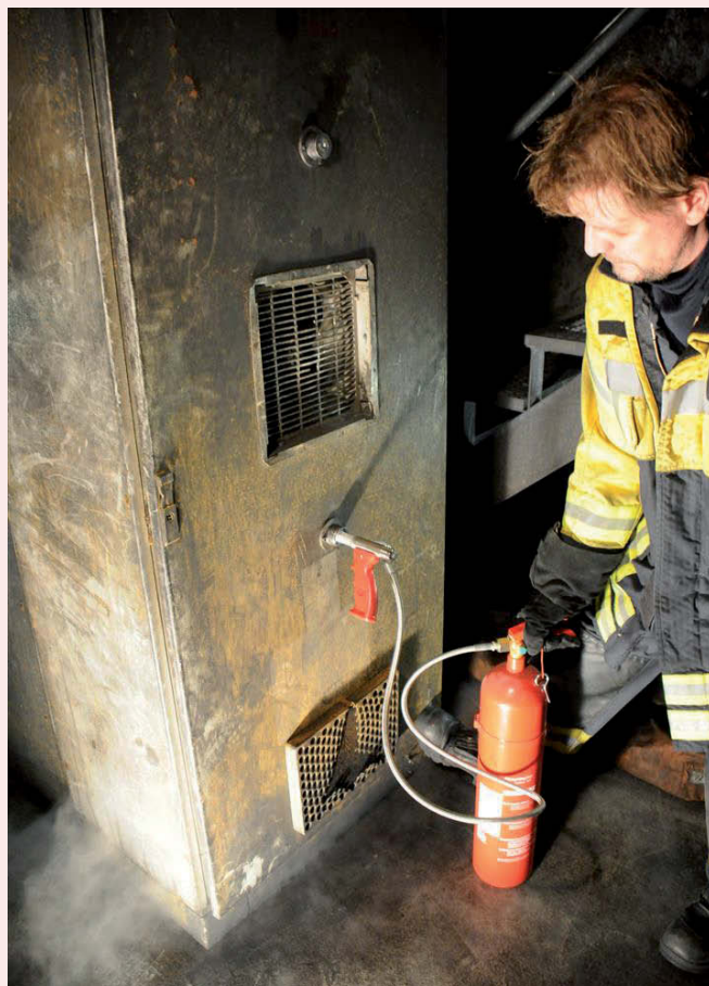
Fognail CO 2 Nagel im Einsatz.
